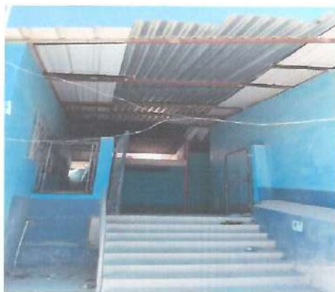
Foto 1: Cambio de cubierta de lamina calibre 26 troquelada y estructura metálica.
